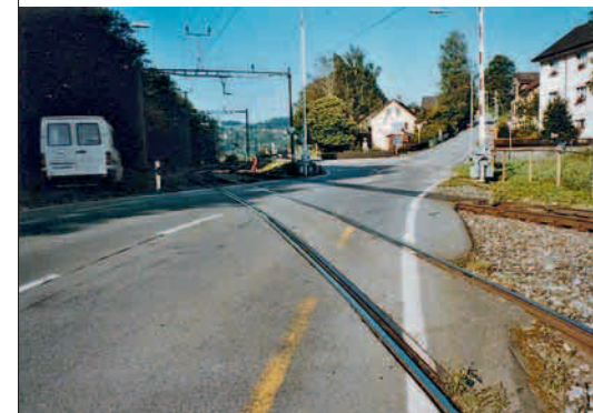
Queren von Schienen in spitzem Winkel | Fran- chissement de rails avec un angle insuffisant | Incrocio di binari con un angolo insufficiente
