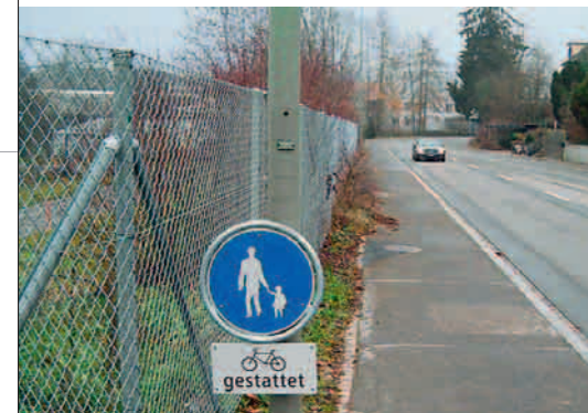
Nutzungsüberlagerung Velo/Fussgänger auf zu engem Querprofil | Vélo et piétons combinés sur une voie trop étroite | Utilizzazione mista: biciclette e pedoni di una sezione troppo stretta
